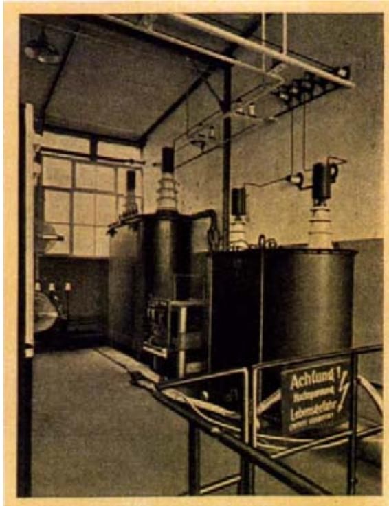
Bild 93. Versuchs- und Prüfanlage für Wasserkühlröhren im neuen Telefunken-Laboratorium, Wernerwerk, Siemensstadt: Die beiden großen Hochspannungstransformatoren. Sie liefern in Verbindung mit Ventilen bis zu etwa 20000 Volt Gleichspannung für die Anodenstromzufuhr bei Leistungen bis über 100 Kilowatt.
